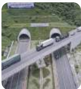
Dự án Hầm Đèo Cả
