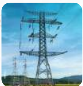
Dự án Đường dây 500kV Quảng Trạch - Phố Mới
