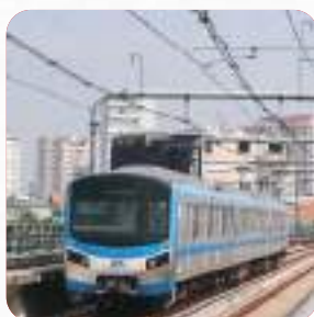
Dự án Metro Bến Thành - Suối Tiên
