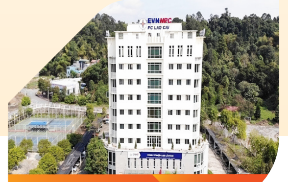
CÔNG TY ĐIỆN LỰC LAO CAI
